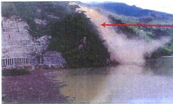
Fotografía 16.7 Activación del derrumbe inicial generando un nuevo desprendimiento de material en la margen derecha. 9 de mayo de 2018.
